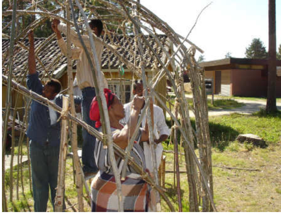
Bygging av hytte, Glomdalsmuseet 2005
